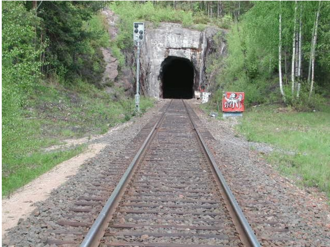
Kuva: Erkki Ritari, Kangasvuoren tunneli
