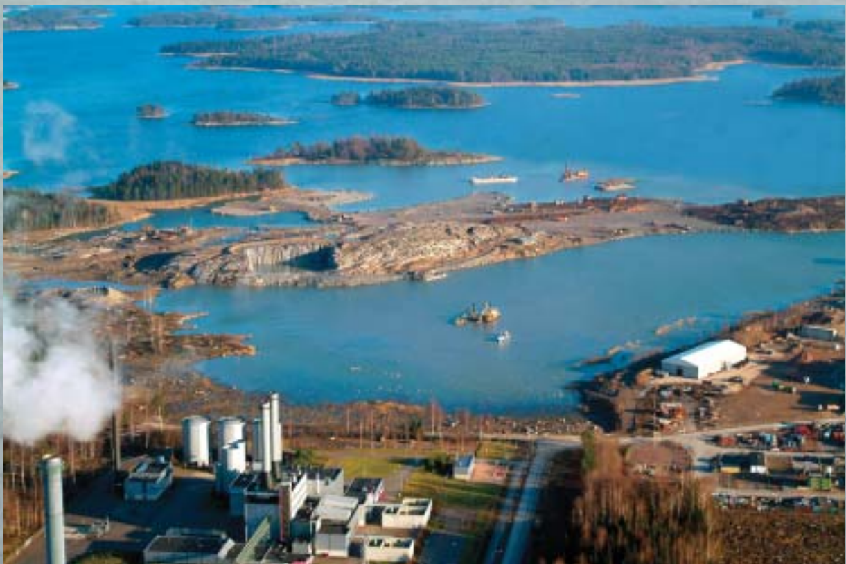
Dredging in Port of Vuosaari.
